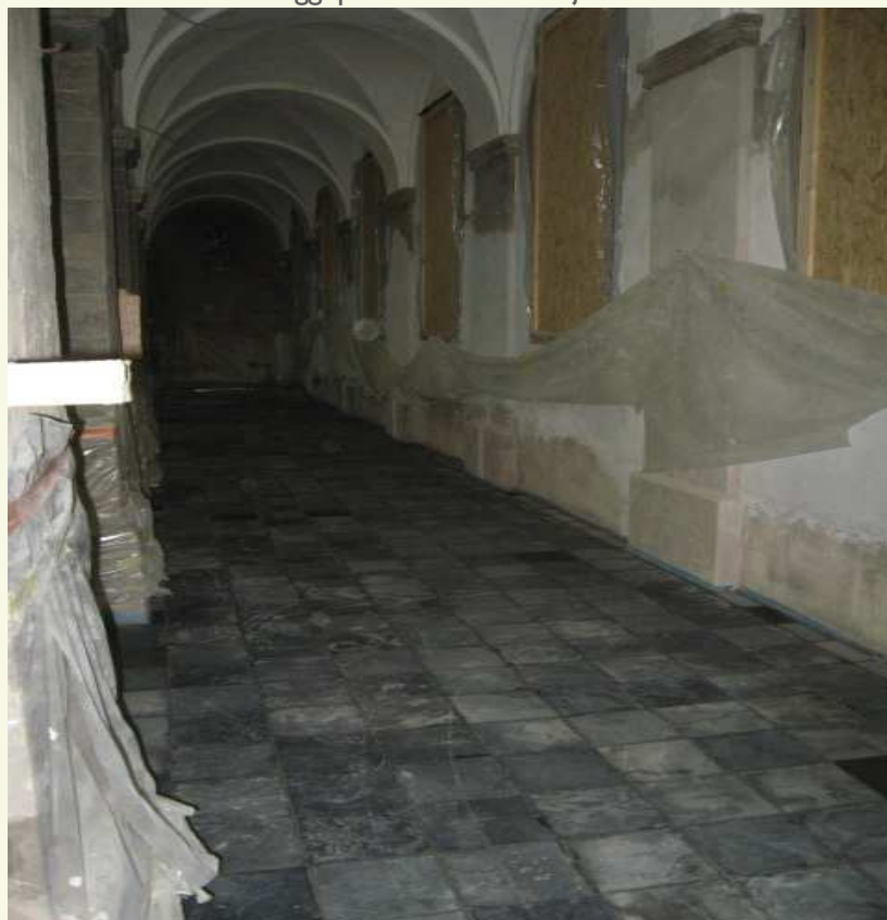
Afscherming klokkenoven , wegneembare metalen bekistingsbakken
