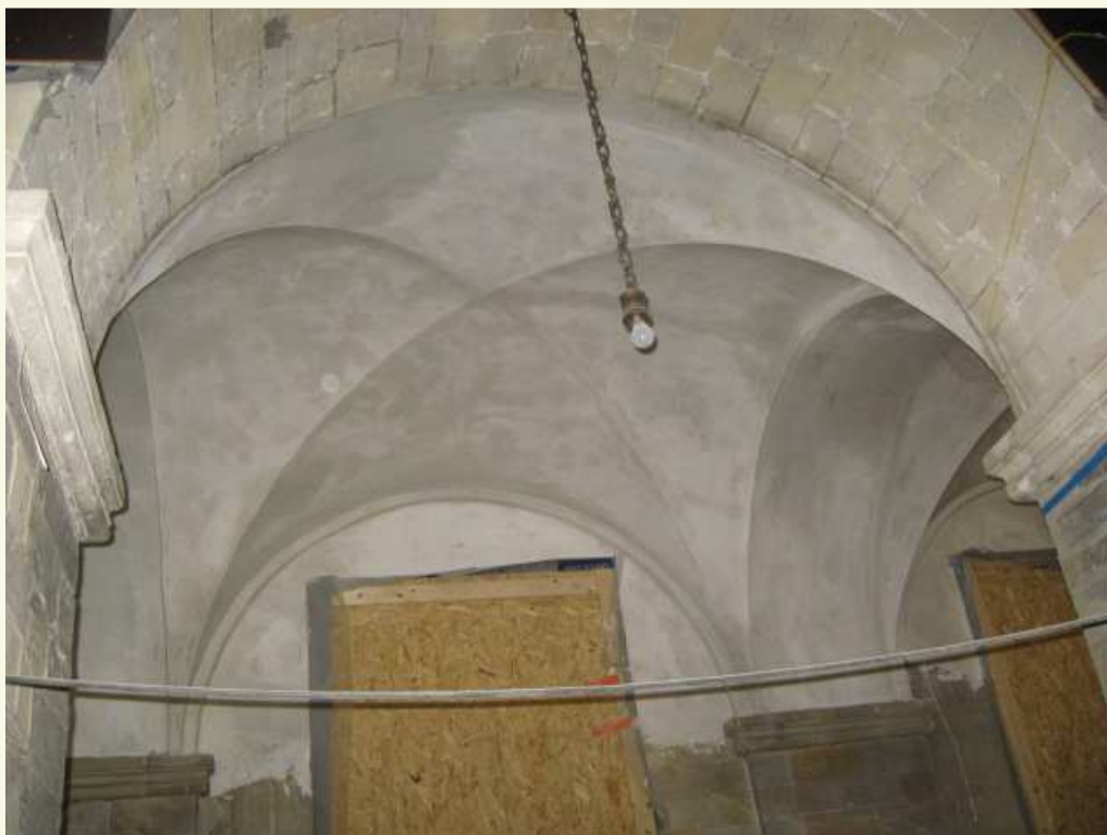
Proefvlakken muurbepoistering grondlaag
