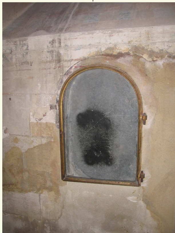
Te herstellen pleisterwerk
