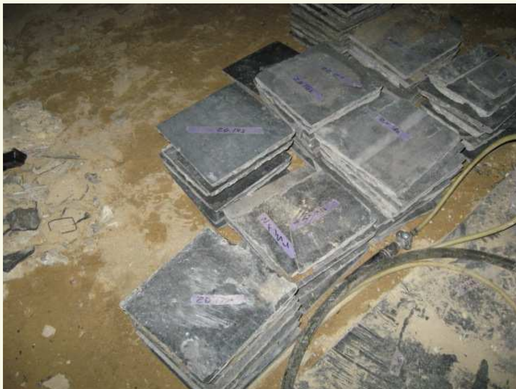
Demontage vloertegels, sorteren per nummer en plaats
