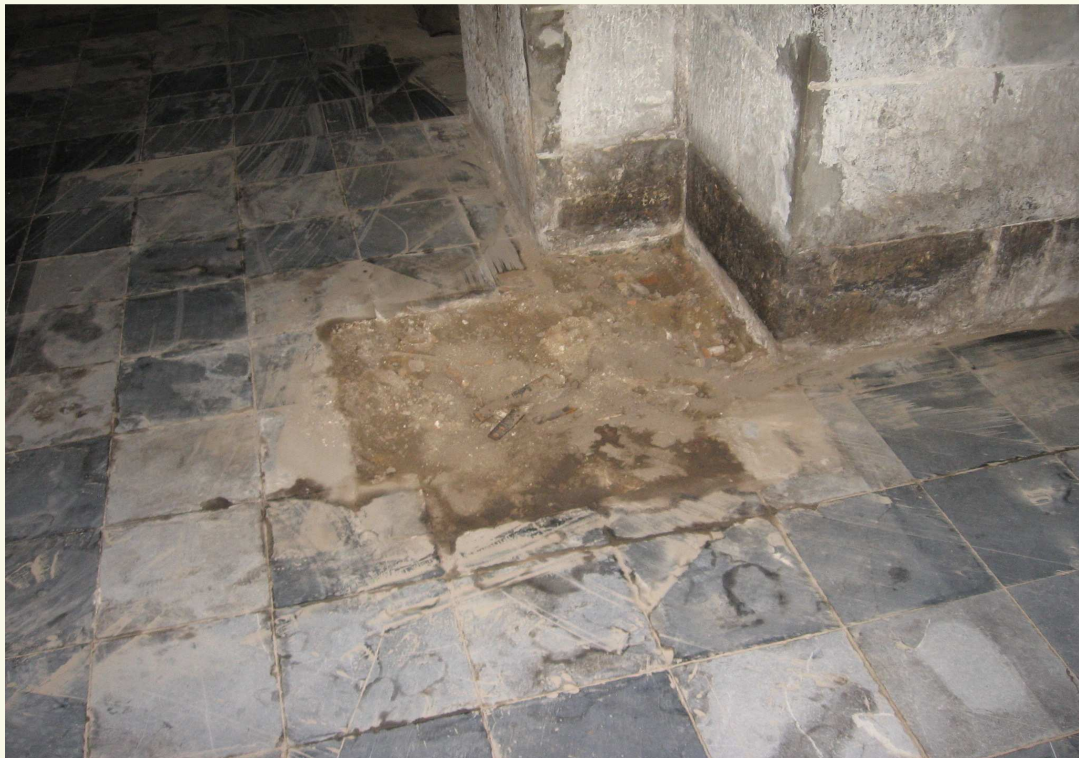
Demontage vloertegels, sorteren per nummer en plaats
