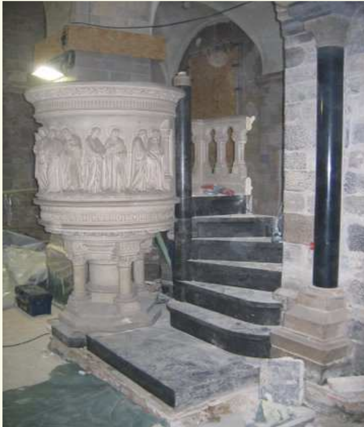
Preekstoel te demonteren en verplaatsen
