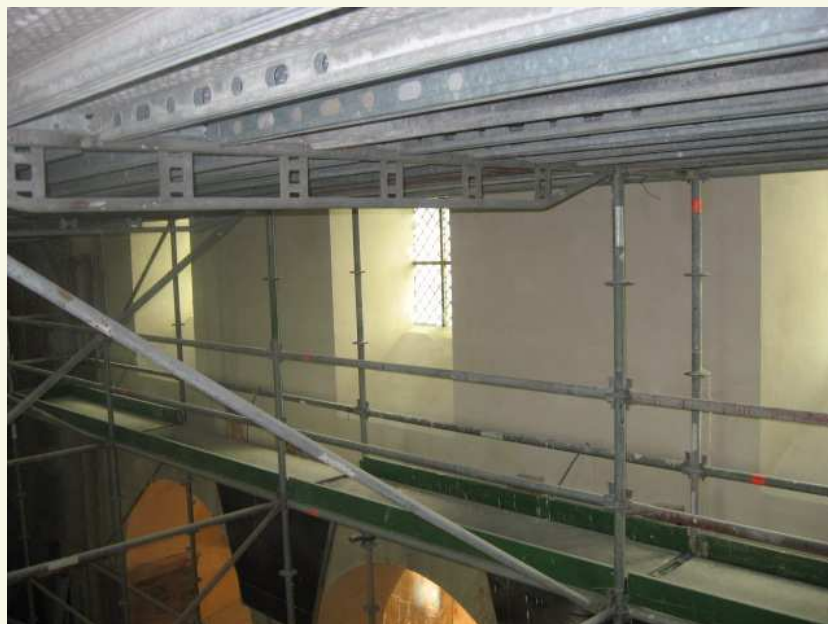
Werken in twee fases, geschilderde wanden, hersteld plafond De stelling verzet naar het volgende deel
