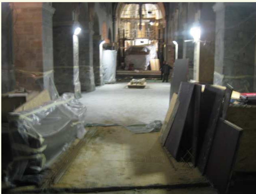
Nieuwe betonnen vloerplaat
