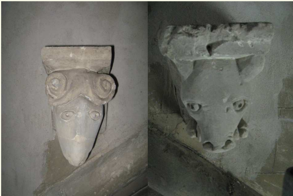
Gereinigde en herstelde sluitsteen bekroning
