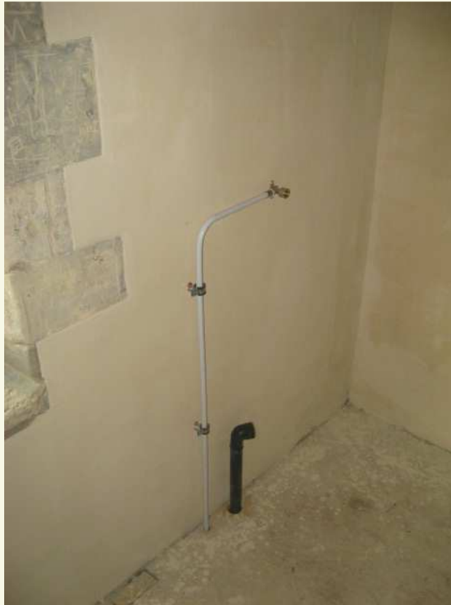
Voorzichtig herstellen van het pleisterwerk rond de bestaande muursjablonen
