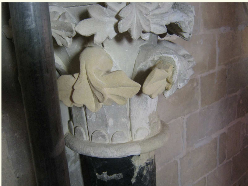
Detail herstelling bladmotieven
