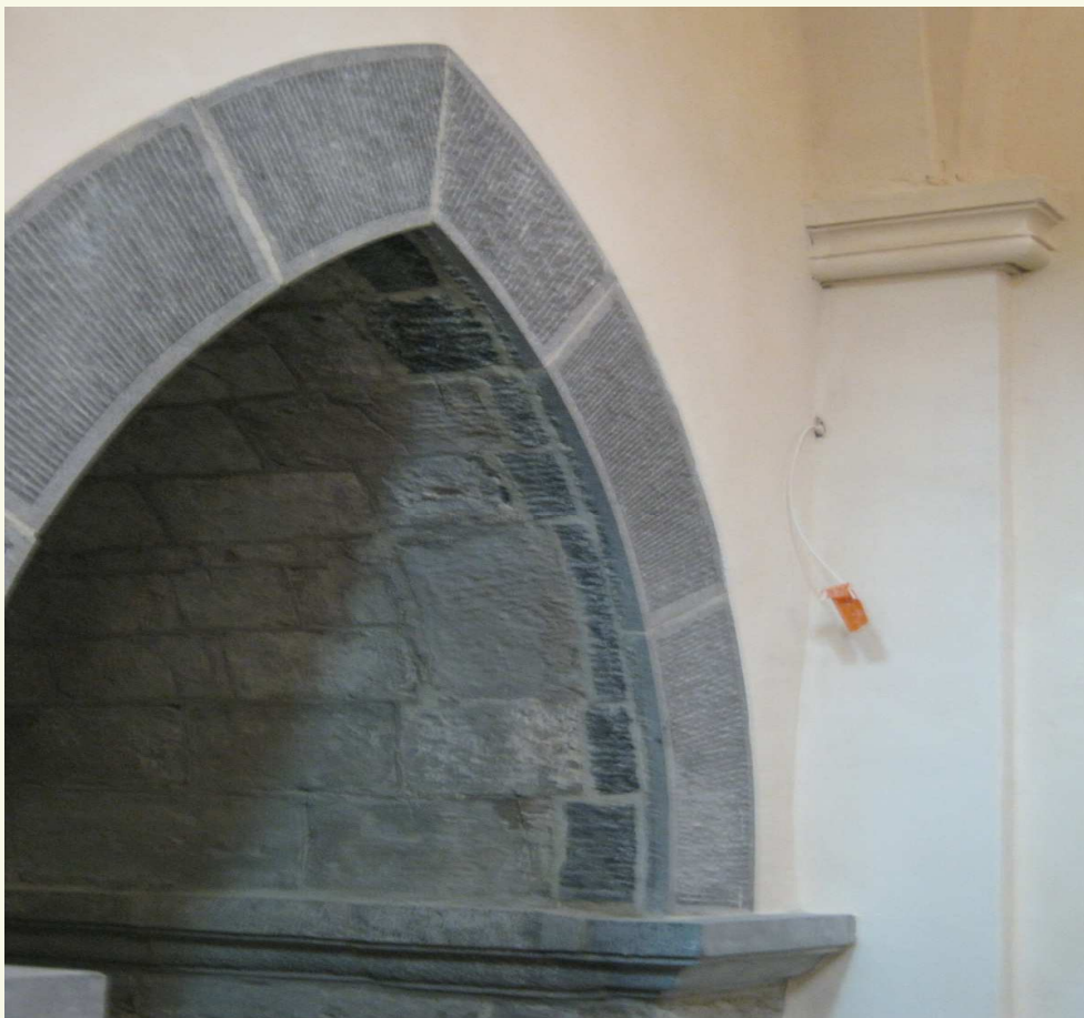
Plaatselijk vervangen natuursteen
