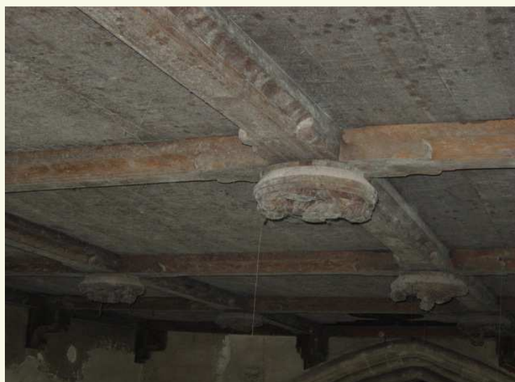
Plaatsen hoofdlijnen verwarming en elektriciteit
