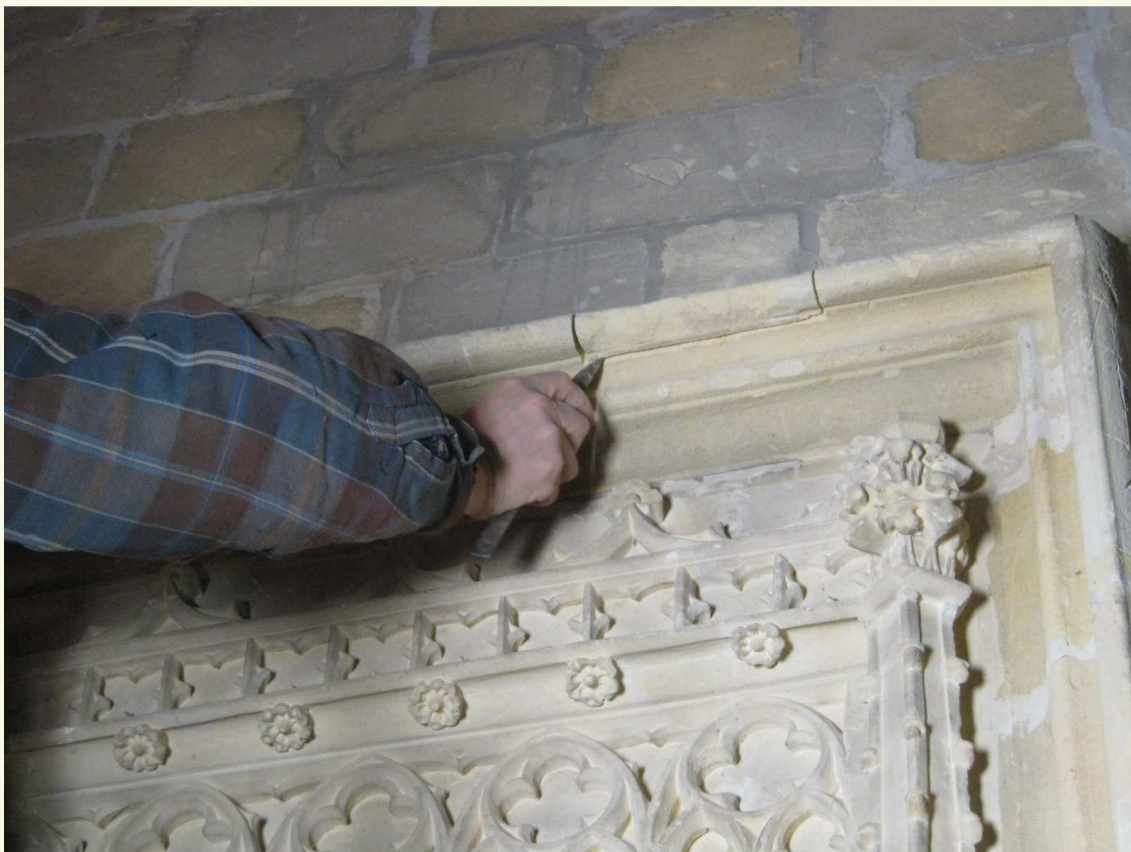
Detail herstelling bladmotieven
