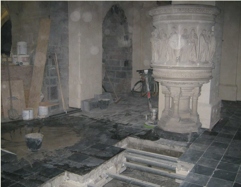
Teruggeplaatste vloeren zijbeuken
