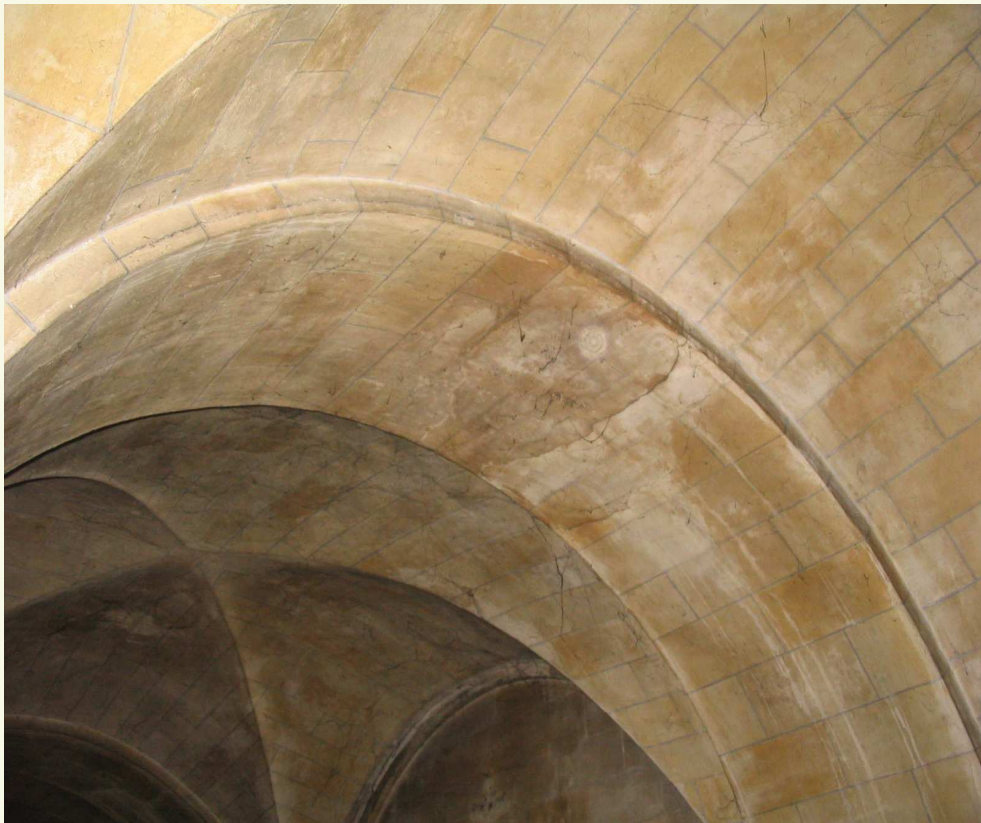
Te herstellen pleisterwerk
