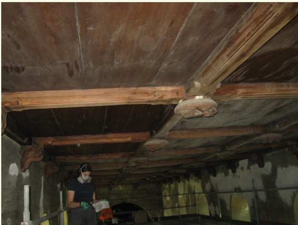
Reinigen en aanbrengen van onderlagen
