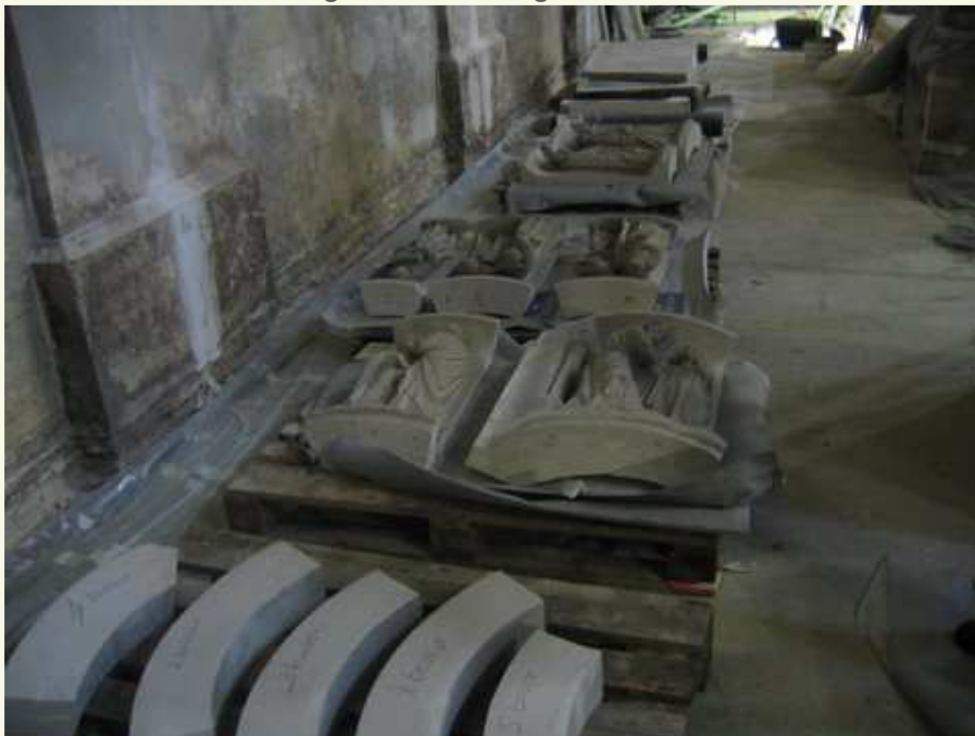
Stockage en nummering van de stukken
