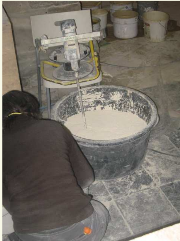
Herstellen en fixeren pleisterwerk , herstellen sjablonen schildering
