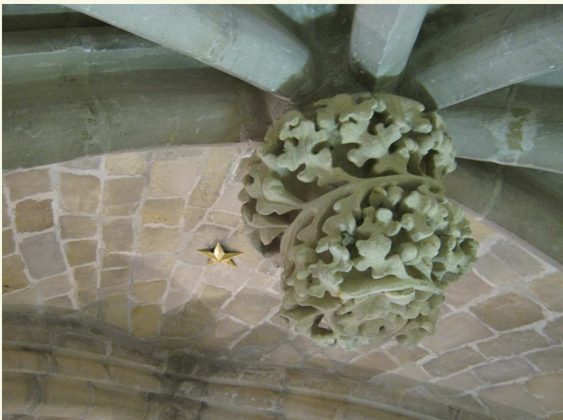
Gereinigde en herstelde sluitsteen bekroning
