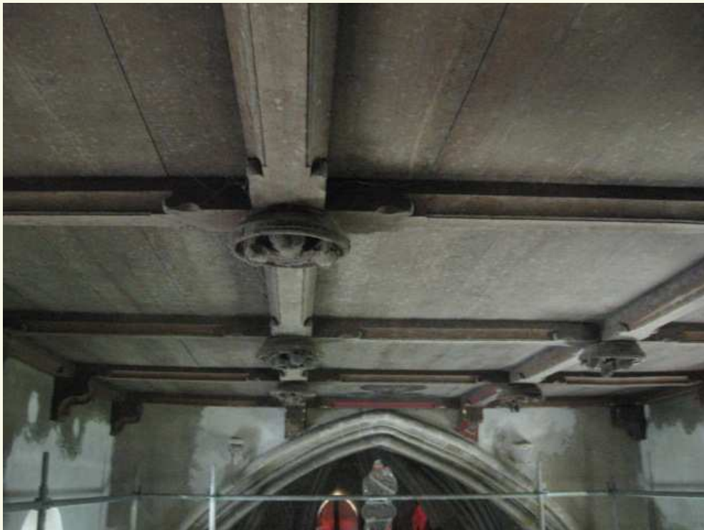
Reinigen en aanbrengen van onderlagen
